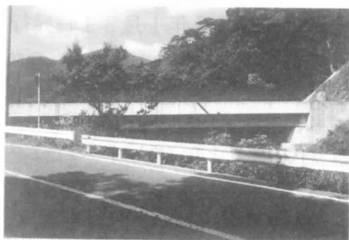
阿須川にかかるバイパス道路の橋
