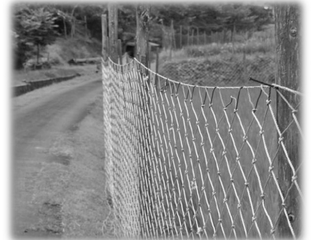
図 3 獣害対策のための柵が設置されている
