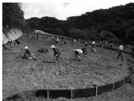
シガラ工の設置
